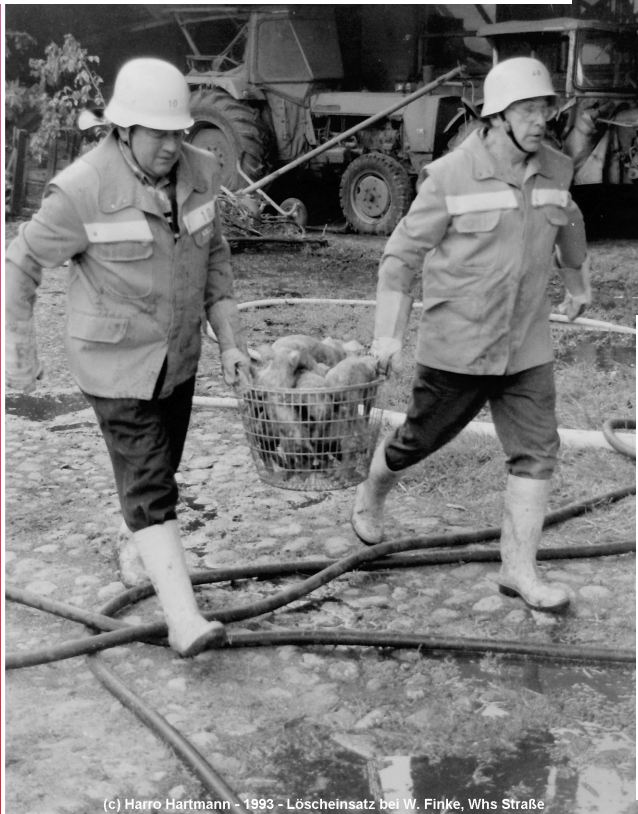
(c) Harro Hartmann - 1993 - Löscheinsatz bei W. Finke, Whs Straße
